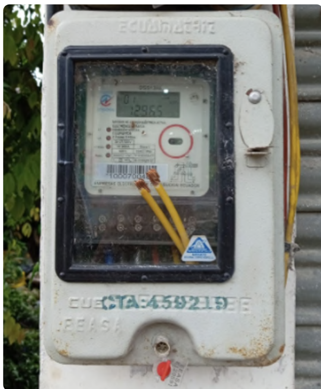
Figura Nro. 1.14: Imagen característica de un equipo de medición con corte.
