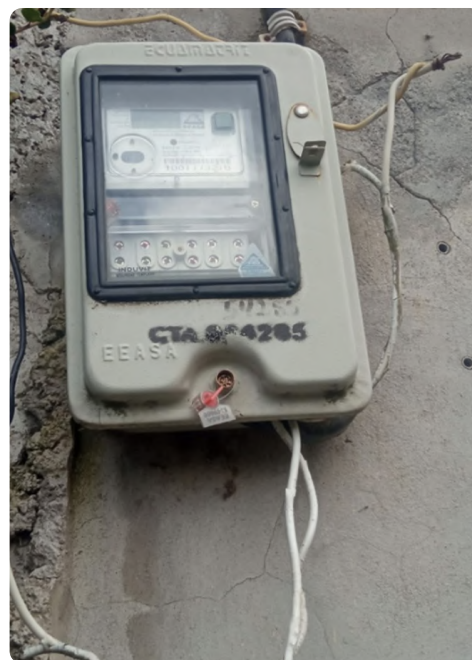
Figura Nro. 1.10: Equipo de medición que dispone de un sello color rojo.
