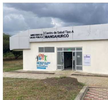
Centro de Salud Tipo A Mangahurco
